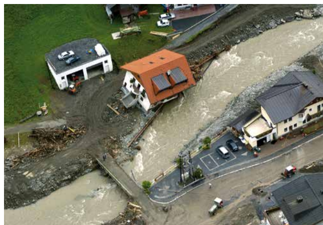
► Overstroming veroorzaakte ernstige schade in Oostenrijk in 2005.
