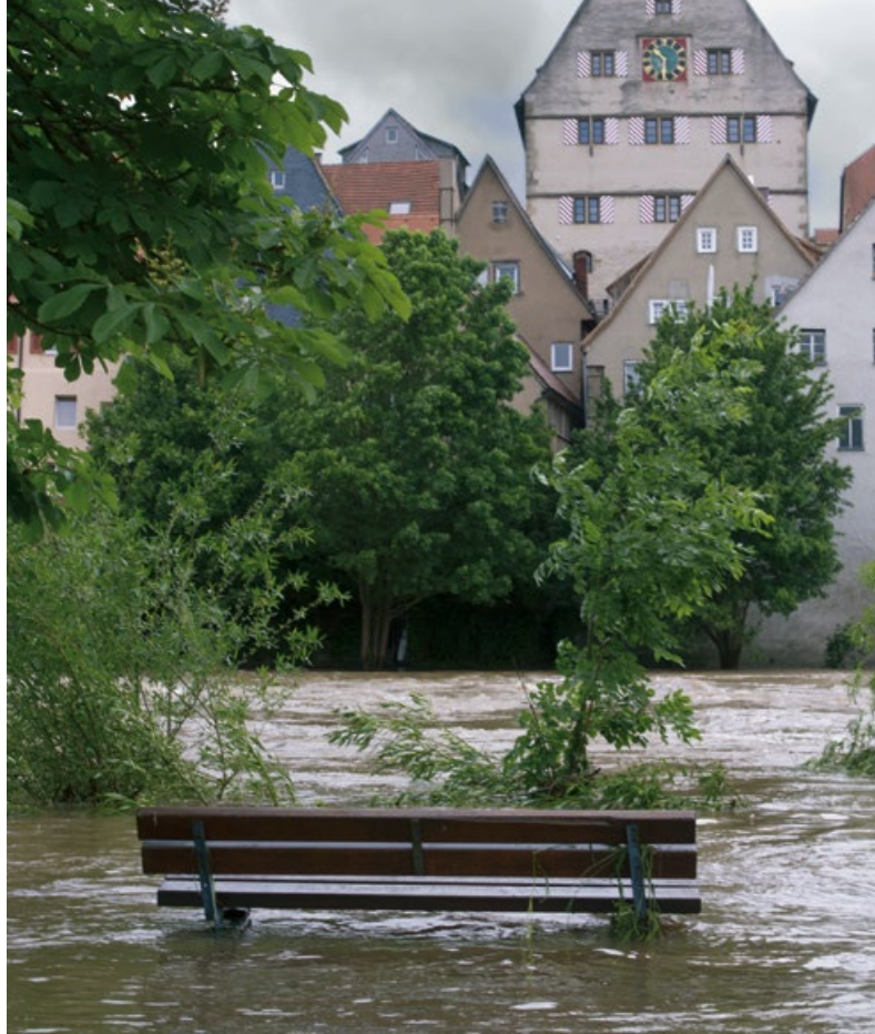
▶Elárasztott park és vízben álló történelmi épületek a németországi Besigheimben 2013 júniusában. A heves esőzések miatt a folyó szintje 5 méterrel a normális vízszint fölött tetőzött.
