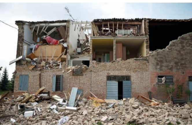
▶ Απόλυτη καταστροφή μετά τον σεισμό στην Emilia-Romagna το 2012.
