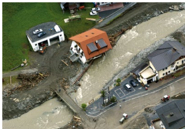
▶Oversvømmelser forårsagede alvorlige ødelæggelser i Østirig i 2005.
