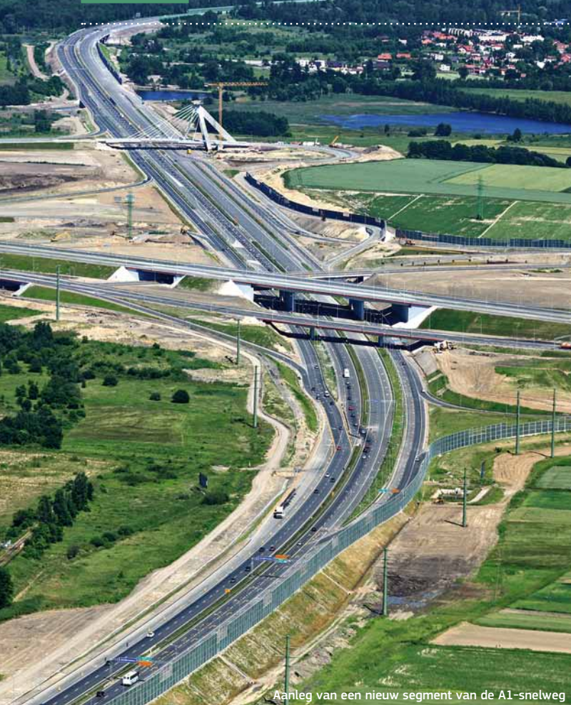
Aanleg van een nieuw segment van de A1-snelweg
