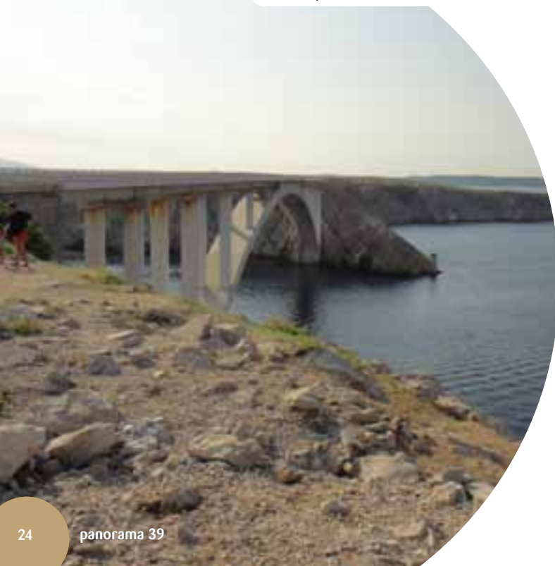
Jižní část ostrova spojuje s pevninou 300 m dlouhý obloukový most
