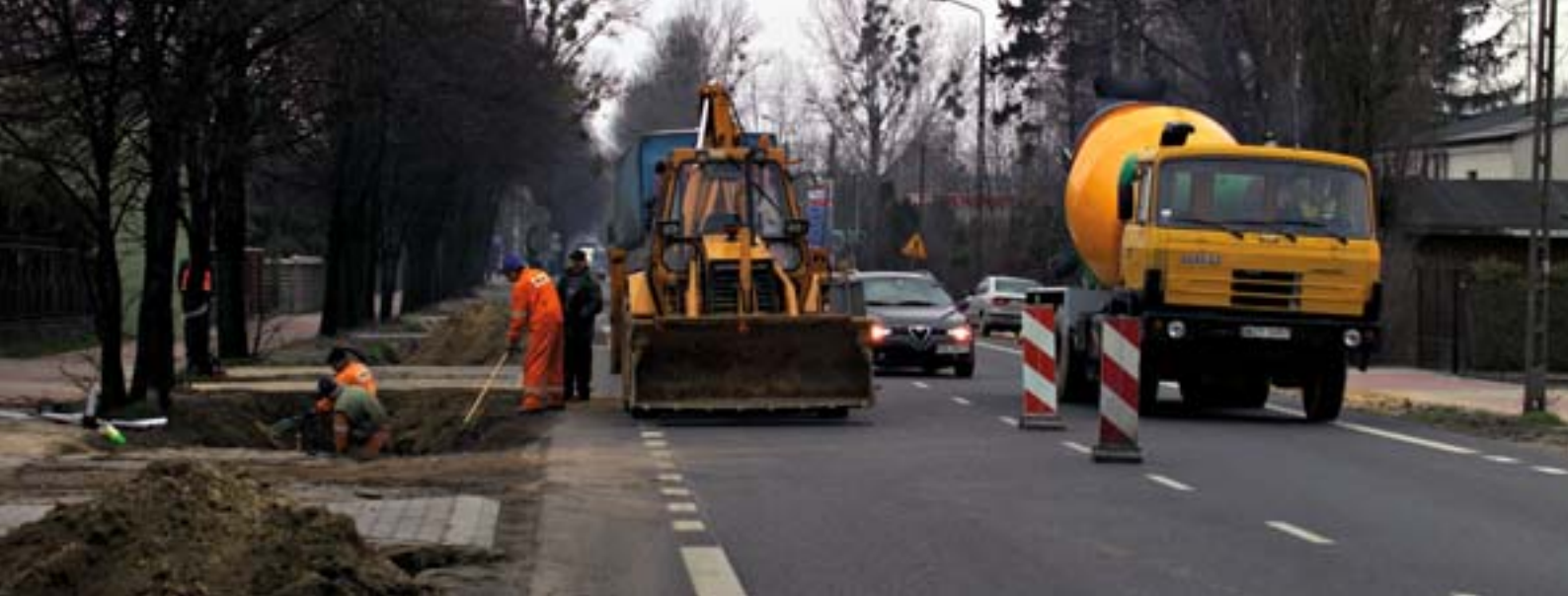
Construcție de străzi, Polonia
