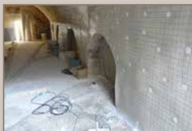
Restauração de alvenaria
