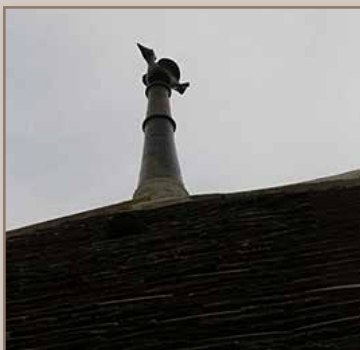
Remise en place des épis de faitage neufs
