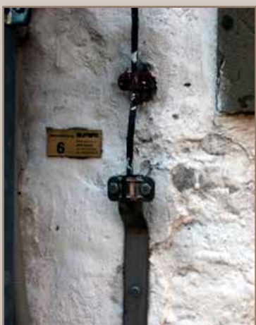
Novo revestimento compára-raios reparado
