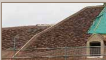
Mistura de telhas antigas e realização do canto médio do telhado da mansarda
