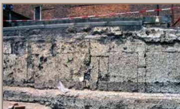
Vidange de la maçonnerie
