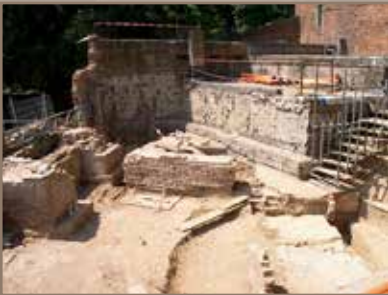
Während der Renovierung (vorne die Südfassade)
