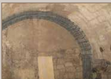
Barras de consolidação
