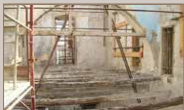
Retirada del piso original
