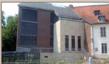
Extension avec cage d'ascenseur sur le côté sud
