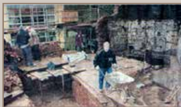
Aushub von Mauerwerk
