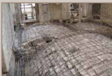
Cupole di consolidamento
