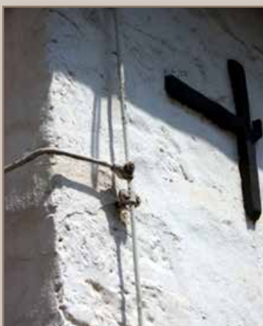
Nuevo yeso de cal con protección antirayos reparada
