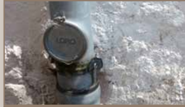
Geänderter Verlauf des Abflussrohrs
