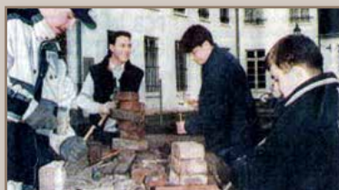
Säuberung/Reparatur von Steinen
