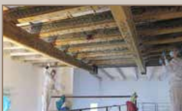
Restauración del techo
