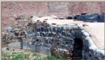
Escavação das fundações
