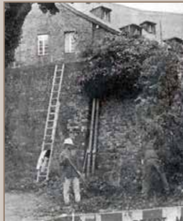
Retirando las plantas con raíces en la mampostería
