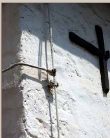
Renovação de Elementos deteriorados
