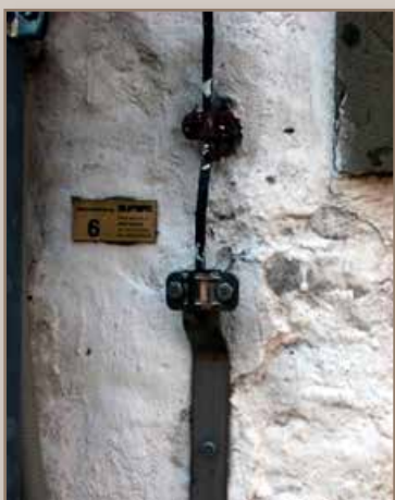
Nuevo yeso de cal con protección antirayos reparada
