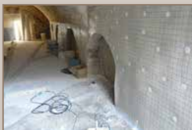
Restauración de la mampostería
