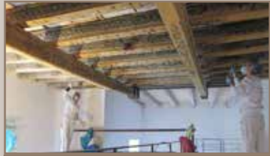
Restauração do antigo teto
