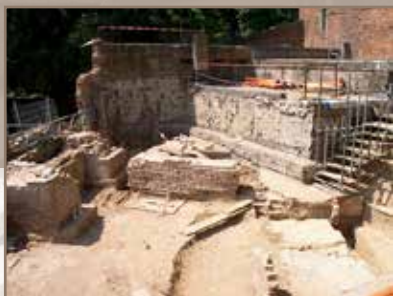
Durante os trabalhos (em frente da fachada Sul)
