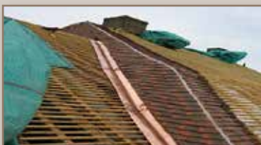
Instalação de caleiras e tubos de queda
