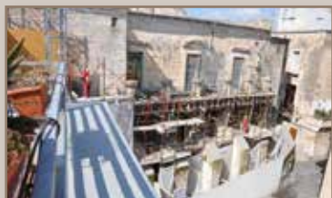
Instalação de andaimes
