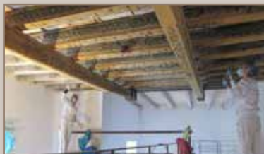
Restauration du vieux plafond
