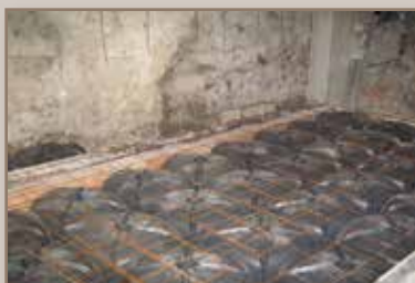
Fondamenta di isolamento
