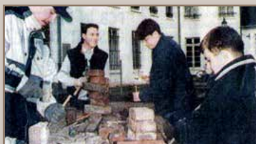
Nettoyage et réparation de pierres brisées
