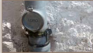
Cambio de dirección de la bajante
