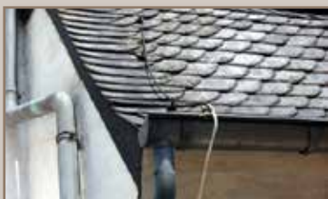
Reabilitação de caleiras
