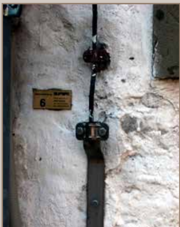
Nouveau plâtre à la chaux avec protection contre les foudres
