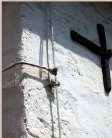
Neuer Kalkputz mit repariertem Blitzschutz
