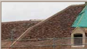
Mischung alter und neuer Fliesen und Realisierung der mittleren Ecke des Mansardendaches
