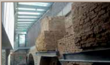
Murs et fondations d'origine intégrés dans la cage d'ascenseur
