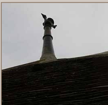
Instalação dos novos acabamentos cerâmicos
