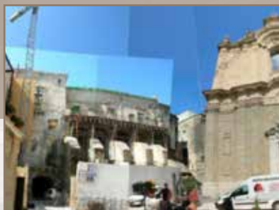
Durante il restauro
