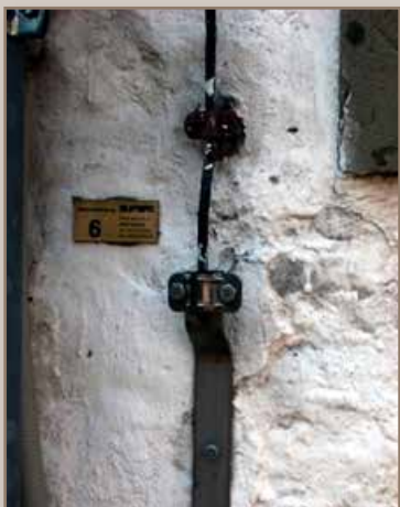
Nuovo intonaco di calce con protezione contro il fulmine
