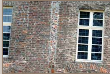
Rotura reparada en la fachada
