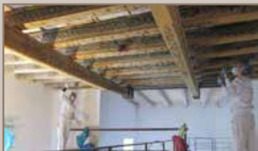
Restaurierung der alten Decke
