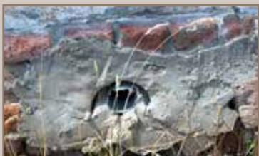
Enlèvement de l'ancien plâtre
