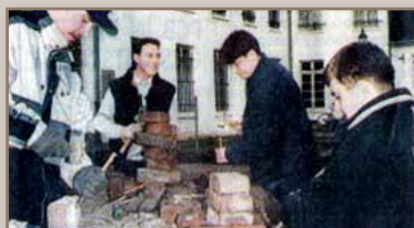
Pulizia e riparazione di rotture
