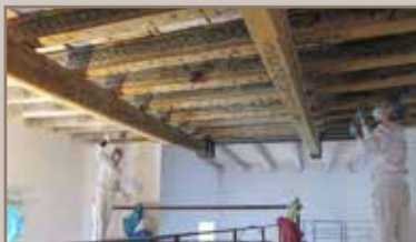
Ripristino del vecchio soffitto
