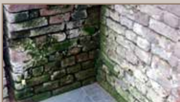
Rimozione muratura bagnata
