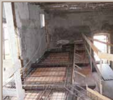
Novas estruturas de concreto armado
