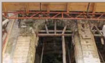
Démolition des balcons d'origine
