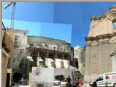
Durante la rehabilitación
