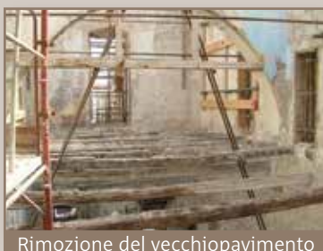
Rimozione del vecchio pavimento
