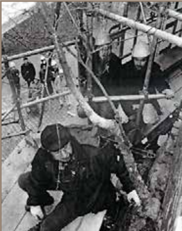
Entfernen der Birke im Mauerwerk
