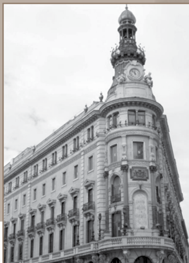
Antes de la rehabilitación
