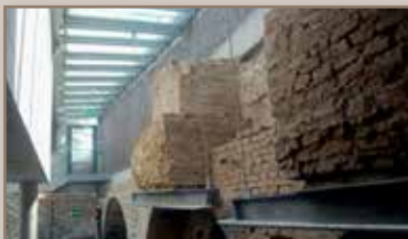
Paredes y cimentaciones originales integradas en el hueco del ascensor
