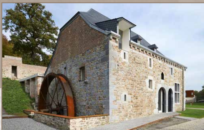
Después de la rehabilitación
