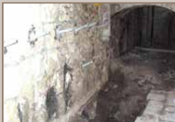
Consolidação das paredes
