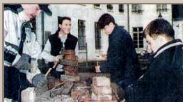
Limpeza e reparação de pedras danificadas
