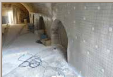
Restauro della muratura
