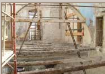
Retirada del piso
