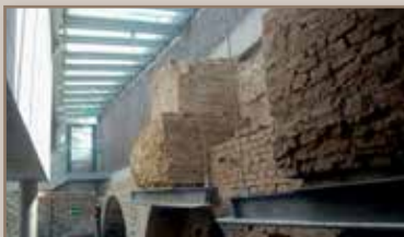
Paredes originais e fundações integradas no eixo do elevador
