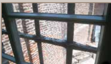
Travaux de métallerie (Métallerie (grilles de fenêtre en fer) et de peinture (cadre de fenêtre en bois)
