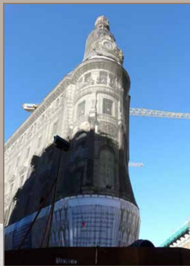
Pendant la rénovation
