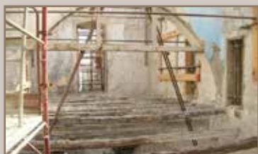
Rimozione dei pavimenti originali
