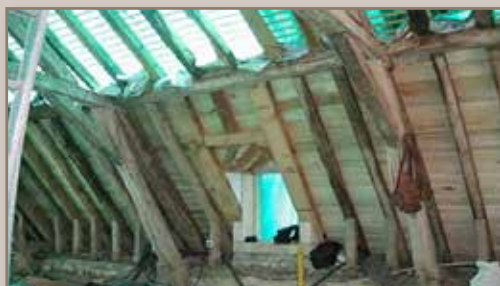
Konsolidierung der Rahmenelemente
