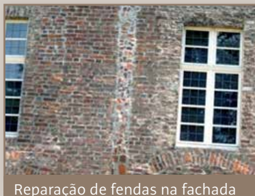
Reparação de fendas na fachada
