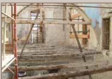
Rimozione del vecchiopavimento
