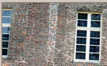
Réparation des fissures dans la façade
