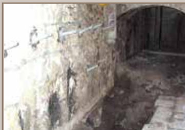
Consolidation des murs
