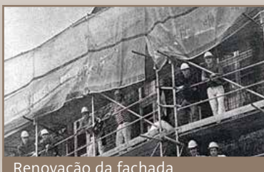
Renovação da fachada
