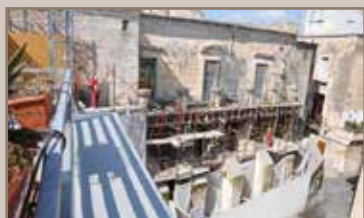
Ponteggi per installazioni
