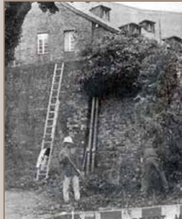
Pflanzen im Mauerwerk entfernen
