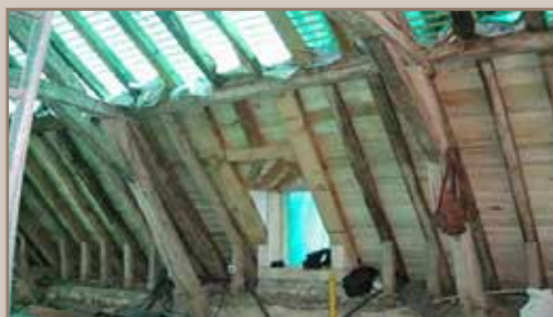
Consolidação dos elementos da cobertura
