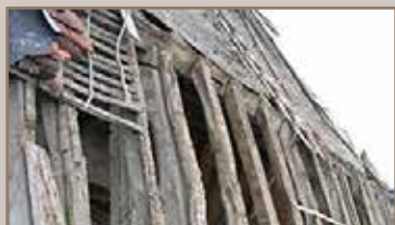
Recolocación de los cheurones
