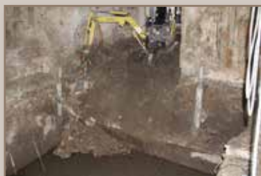
Enchimento do cabo
