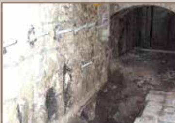
Konsolidierung der Wände
