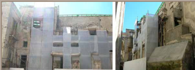
Antes de la rehabilitación
