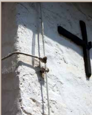
Nuovo intonaco di calce con protezione antiappannamento riparata
