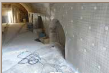
Restauro della muratura
