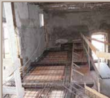
Nuove strutture in cemento armato
