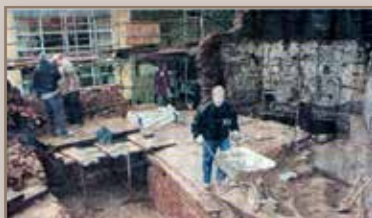
Excavation de la maçonnerie
