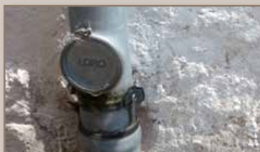
Alterações nos tubos de drenagem
