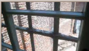
Lavorazioni in metallo (griglie di ferro) e verniciatura (finestra in legno telaio)
