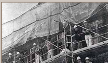
Application d'un nouvel enduit à la chaux
