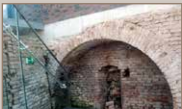
Murs et fondations d'origine intégrés dans la cage d'ascenseur
