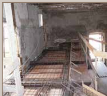
Nueva estructura en cemento armado
