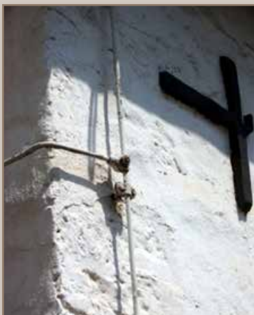
Nouveau plâtre à la chaux avec protection contre les foudres
