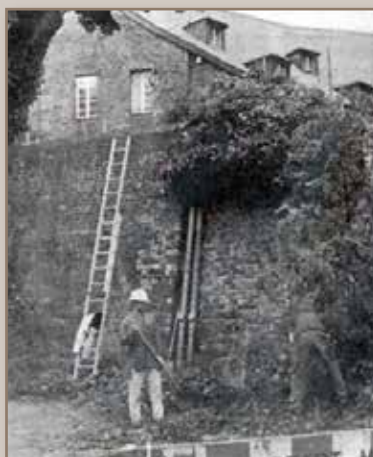
Enlever la végétation dans les murs
