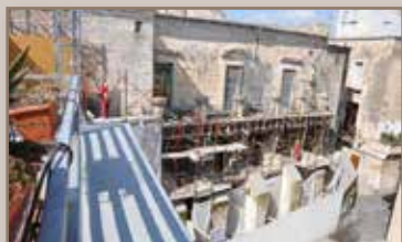
Andamio de instalación
