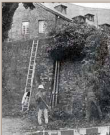
Rimozione delle piante nella muratura
