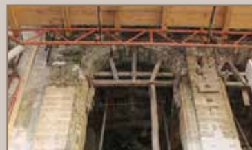
Abbruch der ursprünglichen Balkone
