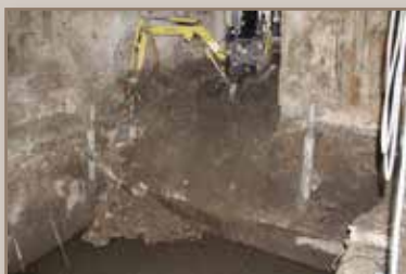
Remplissage de câble
