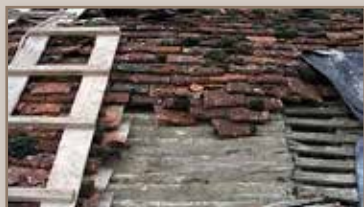
Enlever et enlever les carreaux
