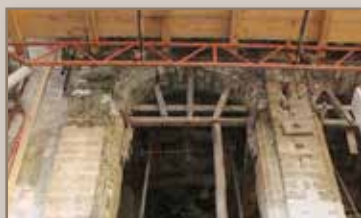
Demolizione dei balconi originali
