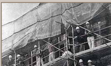
Renovar las juntas (trabajadores haciendo un descanso)
