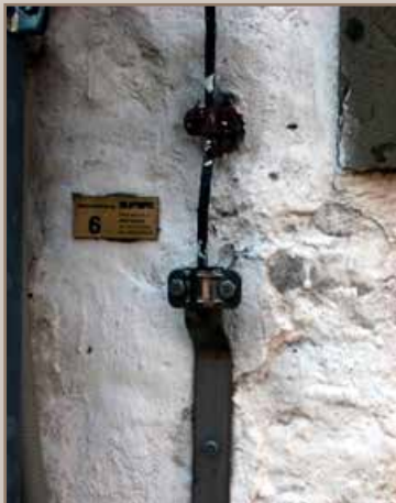
Neuer Kalkputz mit Reparatur Blitzschutz
