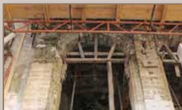
Demolición del balcón original
