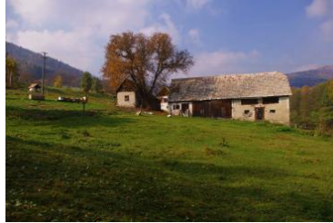
Le propriétaire du rucher entretient et restaure les bâtiments traditionnels (four à pain, écurie et autres bâtiments traditionnels). © Martina Slámová.
