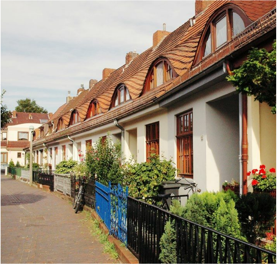
Häuserfassade am Feierabendweg in Bremen Ohlenhof | ASK GmbH Facades in Feierabendweg-Alley, Bremen Ohlendorf
