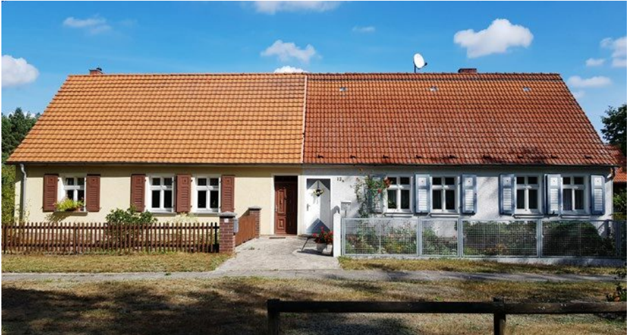
Besonders erhaltenswertes Gutsarbeiter-Doppelhaus im Ortsteil Burow, Gransee | Bruckbauer & Hennen GmbH Typical rural workers' twin houses of high conservation value in Burow village, Gransee
