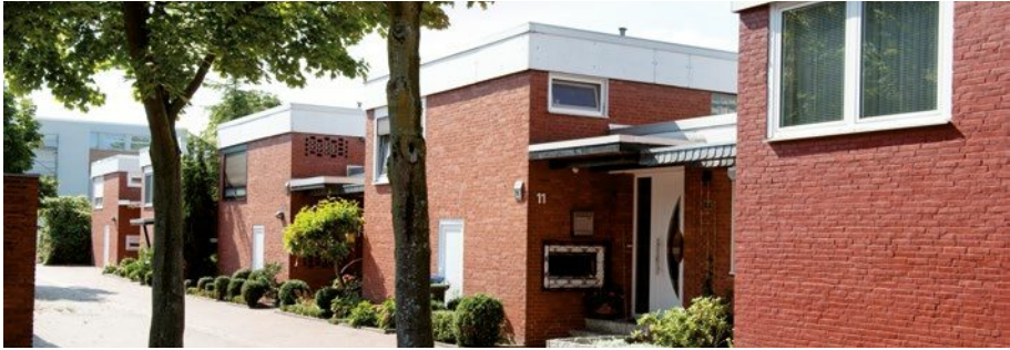
Prototyp-Einfamilienhausvarianten im Trabantenstadtteil Detmerode der Stadt Wolfsburg | complan Kommunalberatung · Varying prototypes of single family houses in the satellite district of Detmerode, Wolfsburg.
