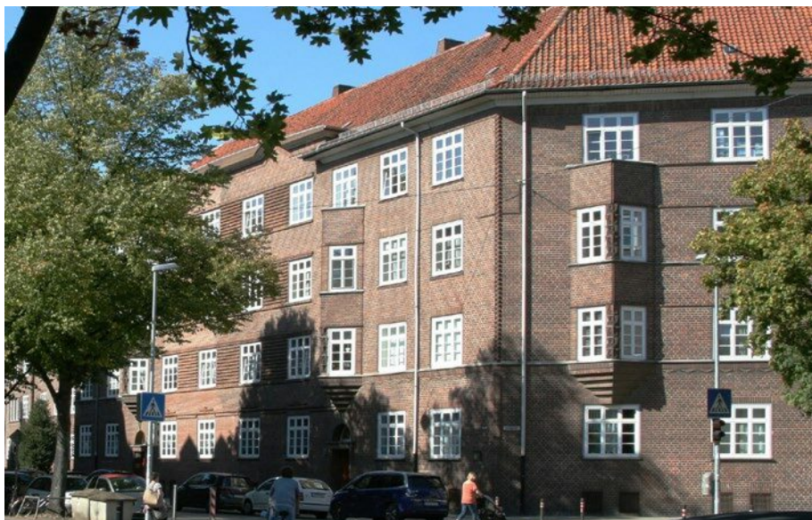
Expressionistische Gestaltungsmotive und einheitliches Fassadenmaterial in der Hannoveraner Südstadt | Dr. Holger Pump-Uhlmann Expressionist shaping and clinker facades are very common in Hanover's Südstadt district.
