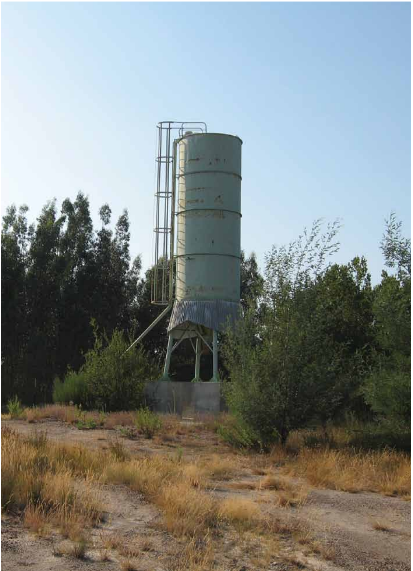
Mina de Vale da Abrutiga – Antigo Silo de Stockagem de cal para o tratamento das águas
