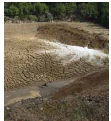
Mina da Quinta do Bispo - Detalhe de uma bacia de decantação. (JB)
