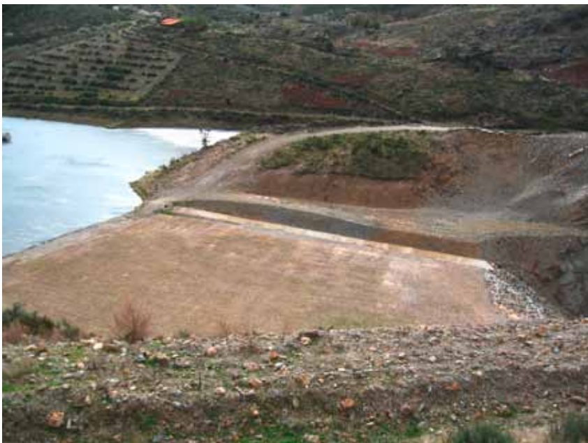
Sustentação de escombreira criando albufeira a montante desta – área mineira de Fonte Santa.
