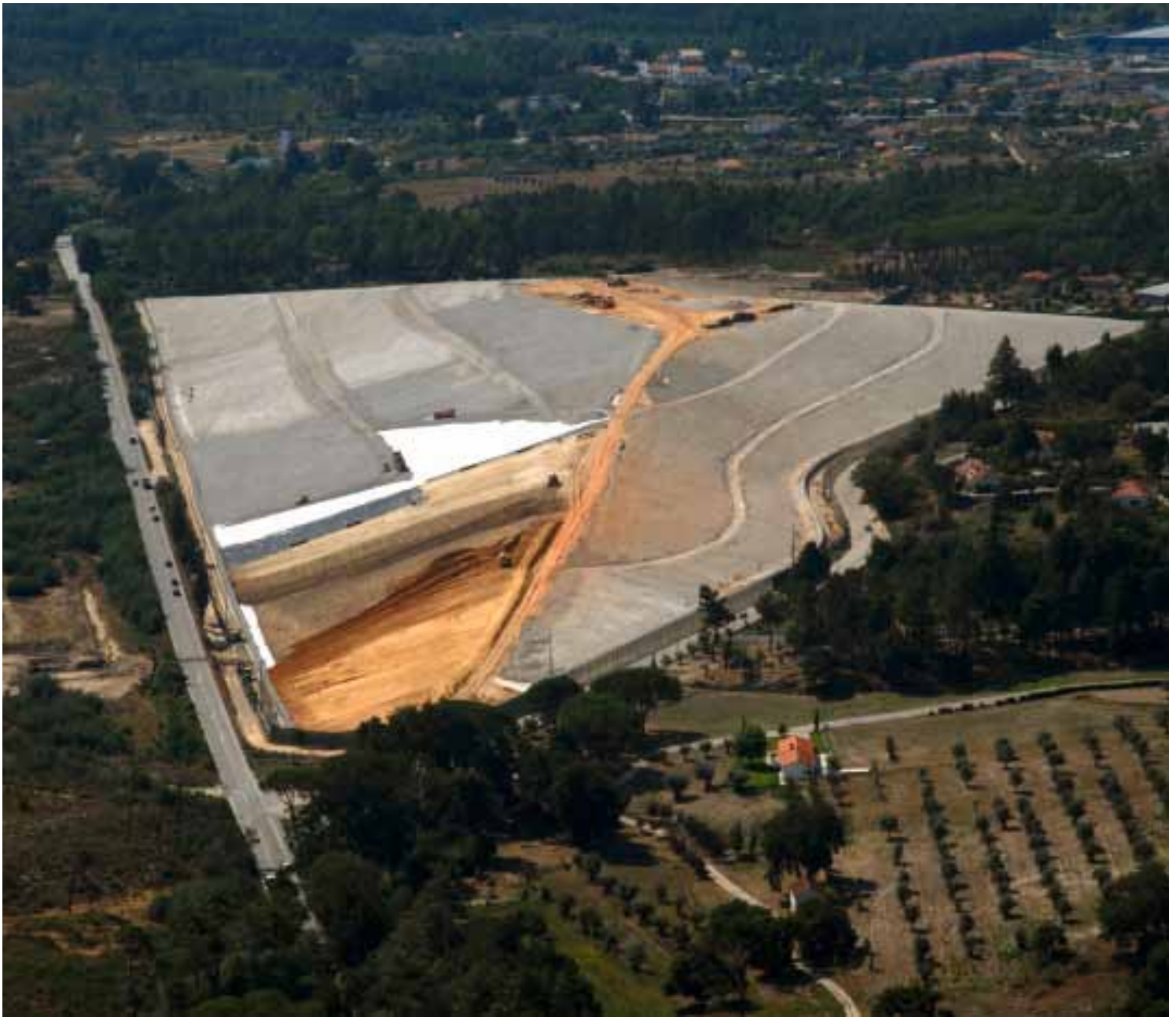
1 Vista aérea evidenciando uma das fases dos trabalhos, após modelação de 3.500.000 m 3
