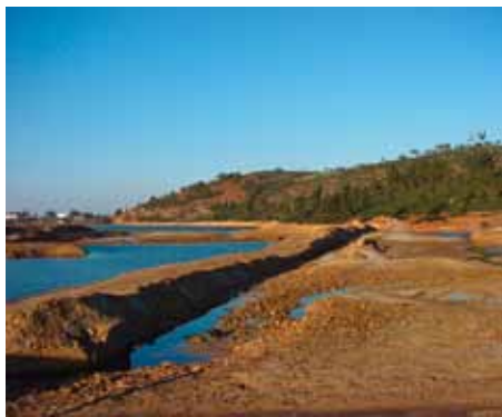
Vestígios do canal periférico à zona mineira de Aljustrel
