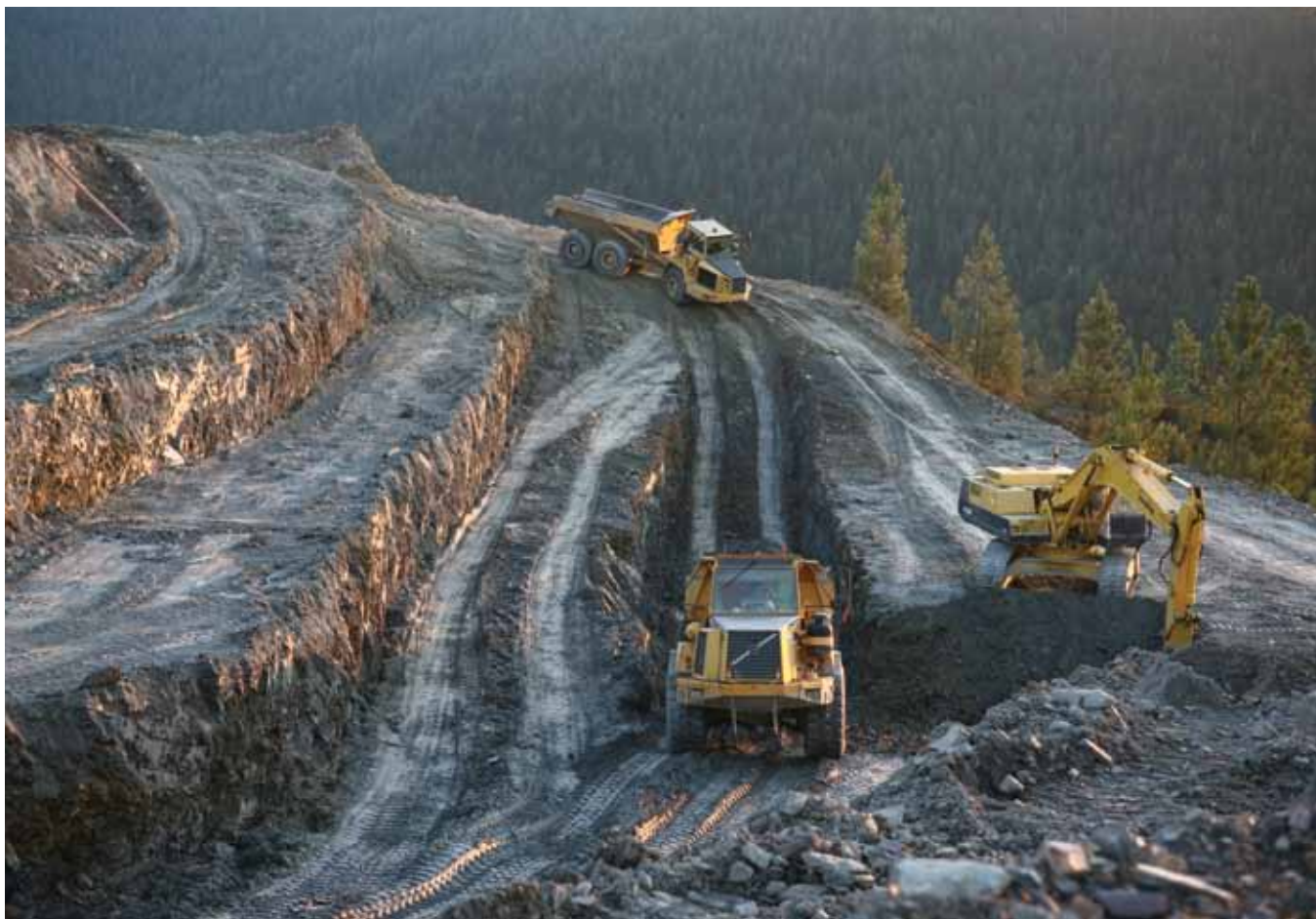
Mina do Vale da Abrutiga - Trabalhos de recuperação. (JB)
