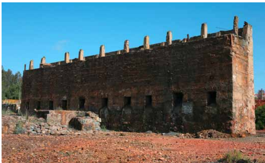
Edifício da descarga do minério (JB)
