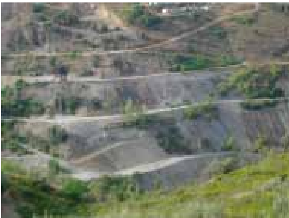
Modelação da encosta com integração de antigos edifícios associados à exploração – área mineira de Ribeira
