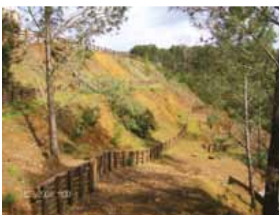
Modelação e coberto vegetal das escombreyras de Covas após selagem, com criação de parque de merendas
