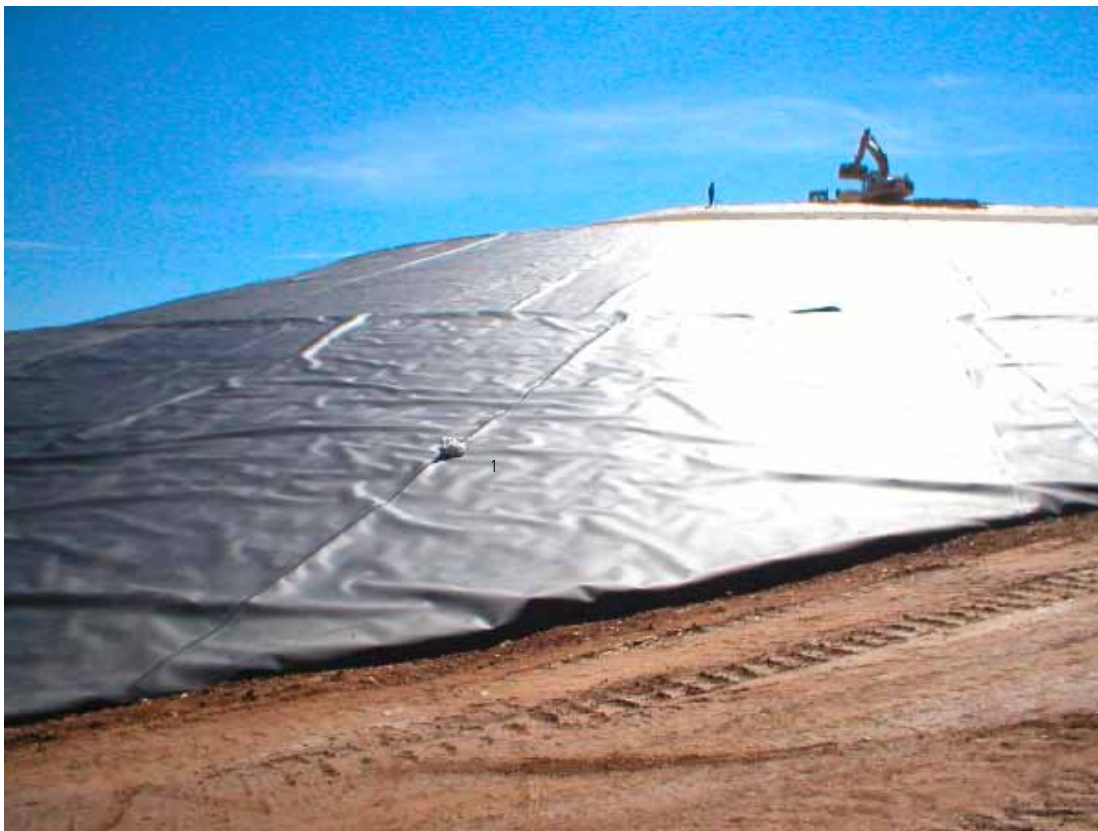
Colocação de geocomposto drenante, geogrelha e camada de terra vegetal
