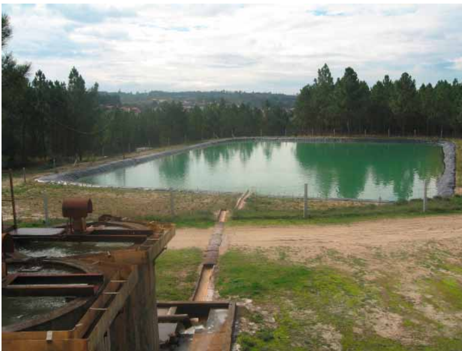
Estação de Tratamento de Água de Mina
