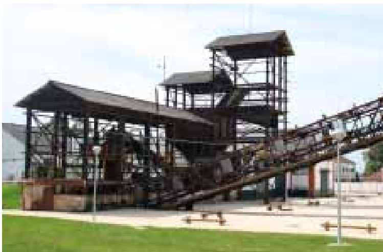
1,2 Beneficiação geral dos equipamentos industriais (britagem secundária, pesagem e transporte de minérios) na área mineira de urânio da URGEIRIÇA.
