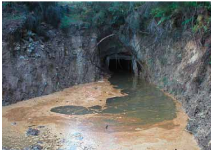
Galeria de esgoto de fundo de mina – Jales
