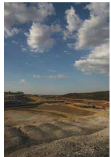
Mina de Aljustrel - vista geral da barragem da água ácida em Aljustrel
