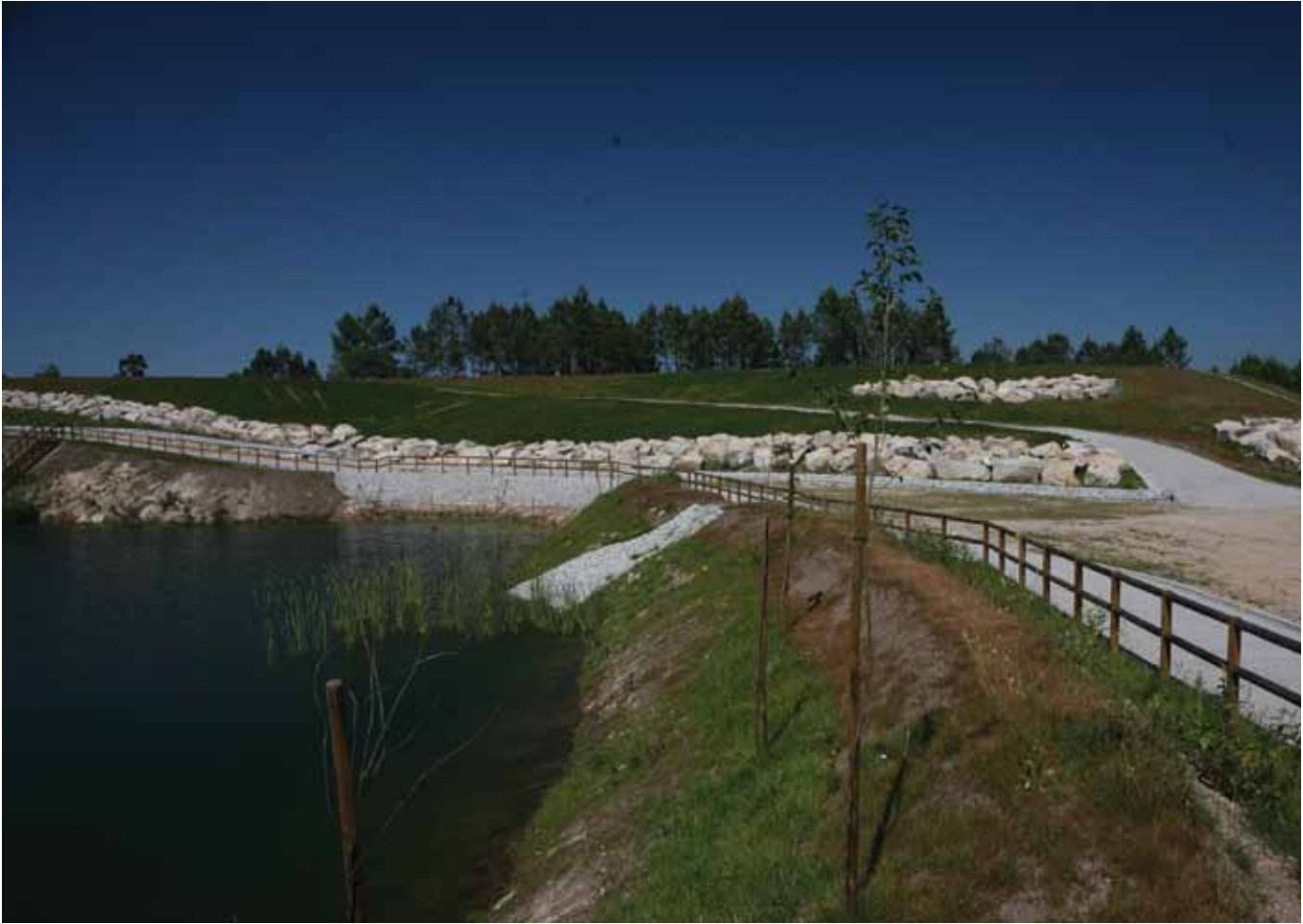
Mina de Espinho - Vista panorâmica após recuperação. (JB) Espinho Mine - Panoramic view after rehabilitation. (JB)
