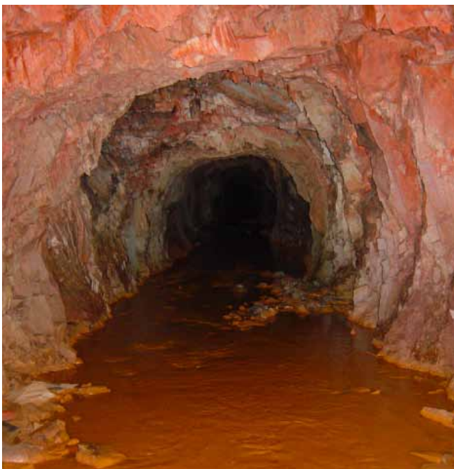
1 Galeria com águas ácidas de pH inferior a 2
