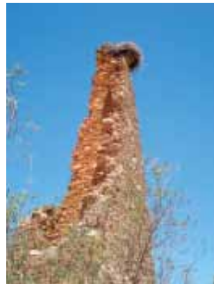
Chaminé da Transtagana destinada à calcinação de pirite - antes e após recuperação
