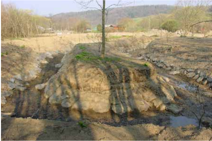
LIFE99 NAT/A/006054 (Vor der Sanierung) Anlage eines Seitenkanals am Wehr „Eibelsau“ mit fließendem Wasser und Vegetation, der Fischwanderungen flussaufwärts ermöglicht.
