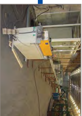
Ricottura in ambiente controllato con forno elettrico
