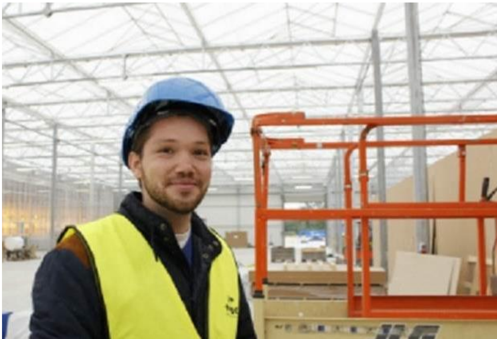
Kuva 19. Uuden kasvihuoneen rakennustyömaa. ©maaseutuverkosto, Mimmi Virtanen.
