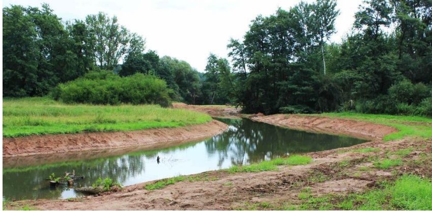
Foto 5: Laufverlegung und Anschluss eines Altwassers an die Rhume oberhalb von Bilshausen
