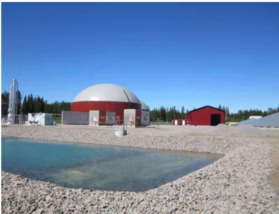
Инсталацията за биогаз Alvesta преработва оборски тор, отпадъци от кланица и дестилерия на сиропи. Биогазът се продава на местната бензиностанция, на енергийна компания и на близкия град.
