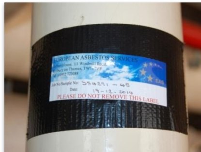
Rúrka s označením azbestu, zdroj: UEPG.
