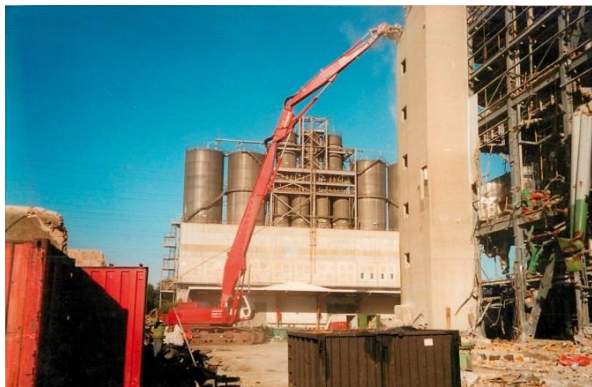
Șantier de demolare. Sursă: VERAS
