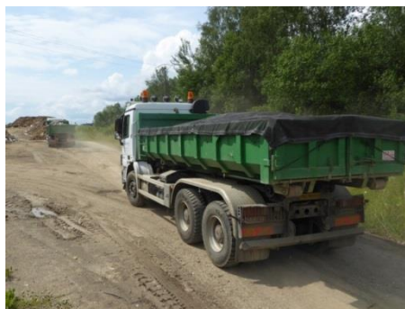
Transportul deșeurilor din construcții și demolări cu camionul, Sursă: A2Conseils sprl
