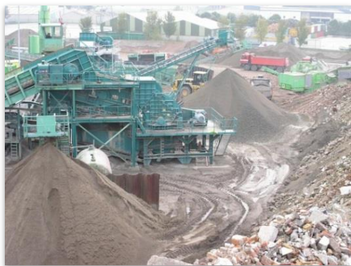
Zakład recyklingu odpadów z budowy i rozbiórki, źródło: FIR
