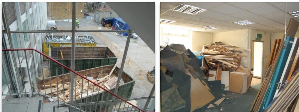
Segregacja u źródła na terenie rozbiórki, źródło: UEFG.
