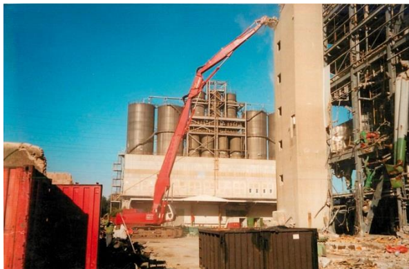
Teren rozbiórki. Źródło: VERAS.
