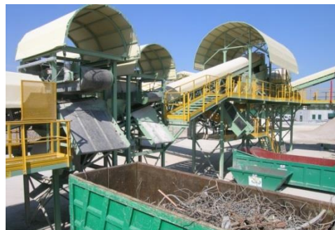
Recyclinginstallatie voor bouw- en sloopafval, Bron: ANPAR
