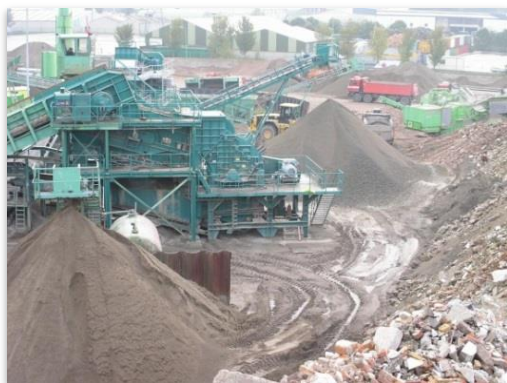
Recyclinginstallatie voor bouw- en sloopafval, bron: FIR
