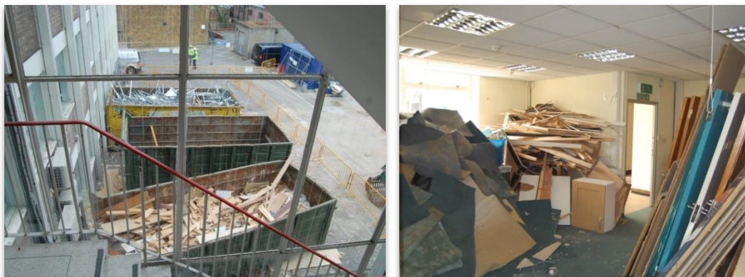
Separazione alla fonte e presso un cantiere di demolizione, fonte: UEPG
