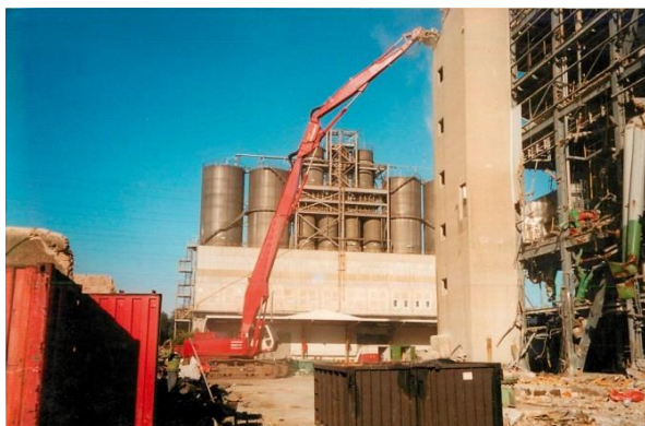
Cantiere di demolizione. Fonte: VERAS
