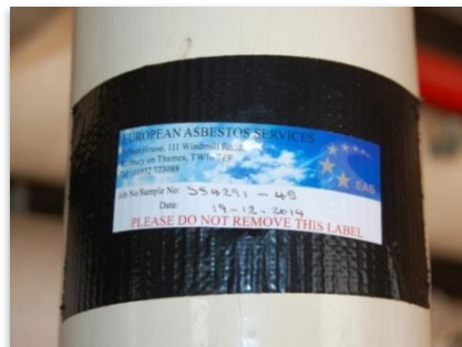
Cijev s oznakom azbesta, izvor: UEPEG
