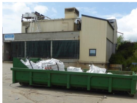
Kontejner s azbestnim otpadom, izvor: A2Conseils sprl
