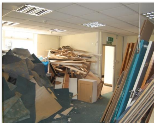
Tri à la source sur un chantier de démolition. Source: UEPG
