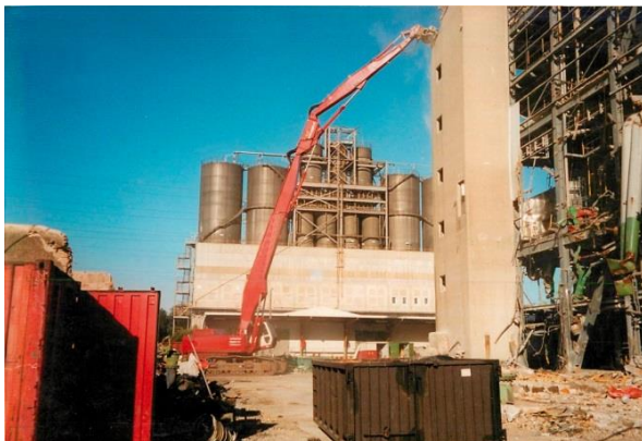
Εργοτάξιο κατεδάφισης. Πηγή: VERAS
