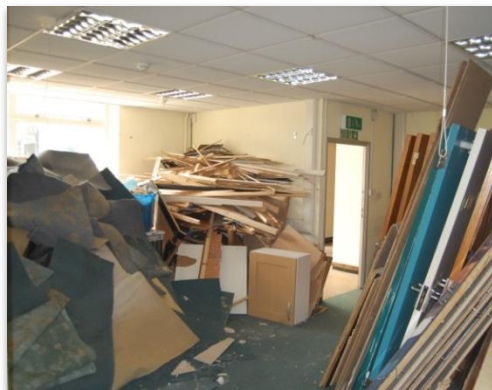
Разделяне при източника на площадката, където се извършва разрушаването, източник: UEPG
