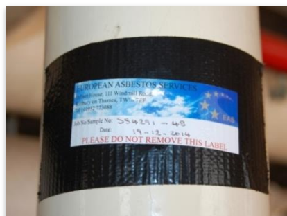
Маркирана за азбест тръба, Източник: UEPG
