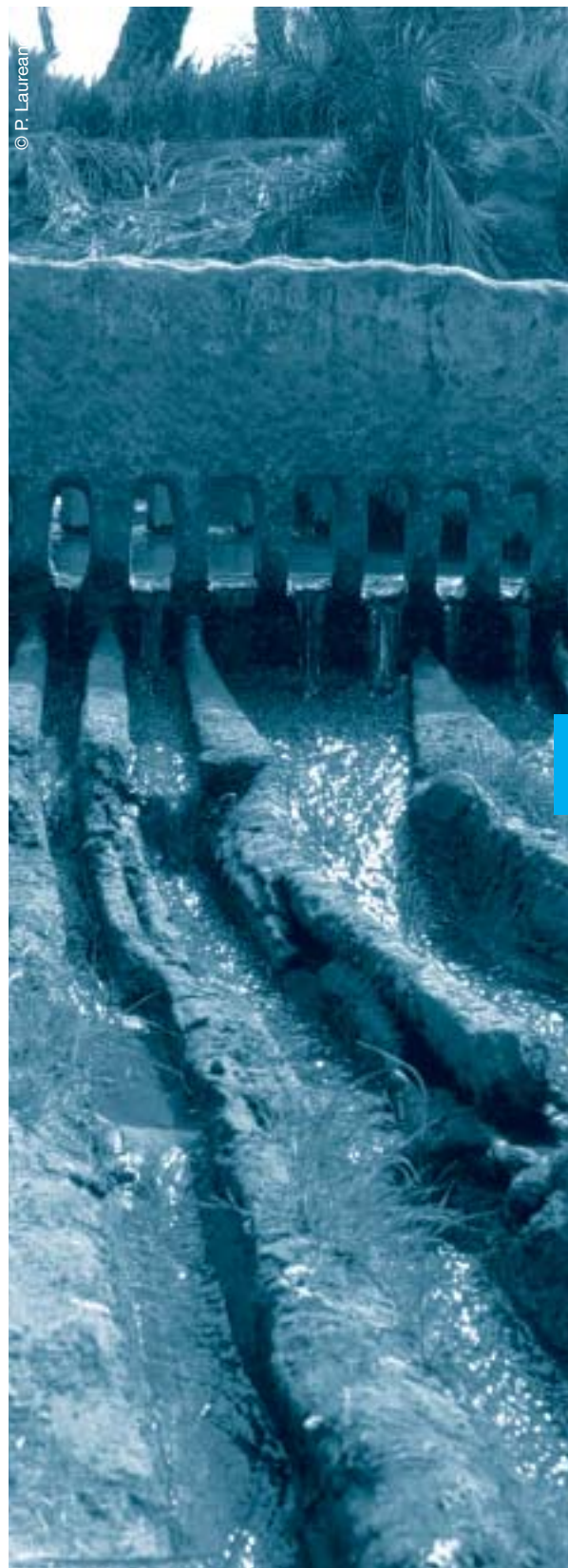
Oásis de Timimoun (Sara argelino) com uma “kesria”, um sistema de distribuição de água por quotas.
