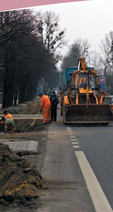
Modernizacja nawierzchni drogi krajowej Mińsk Mazowiecki-Sochaczew
