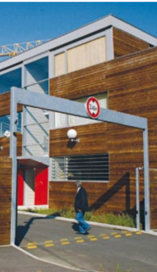
● L'Europe participe activement à la requalification des cités. Ici à Grigny, dans l'Essonne, avec la construction de bureaux et d'ateliers pour favoriser la création et le développement d'entreprises.
