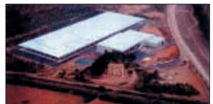
Vista da central de compostagem
