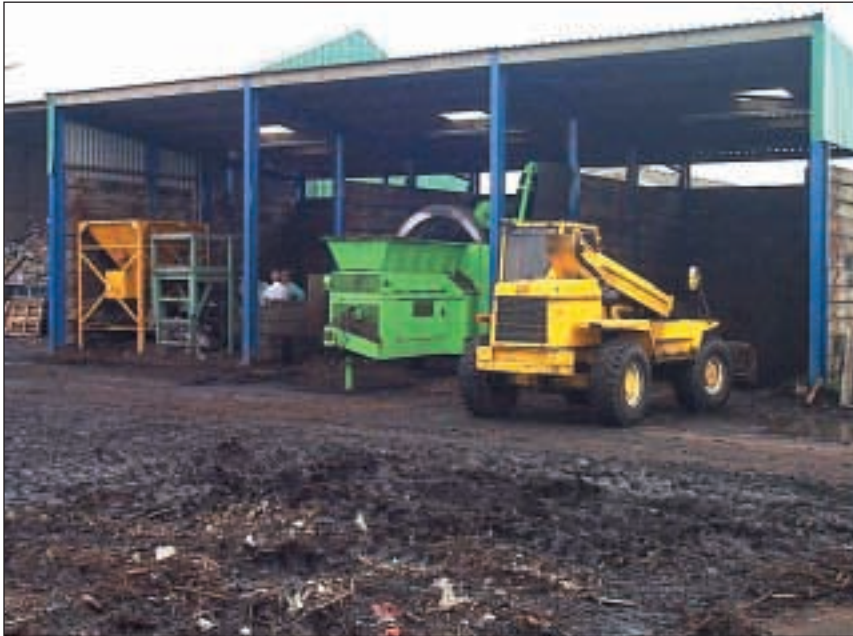
Pavilhão utilizado para a crivagem e ensacamento do composto
