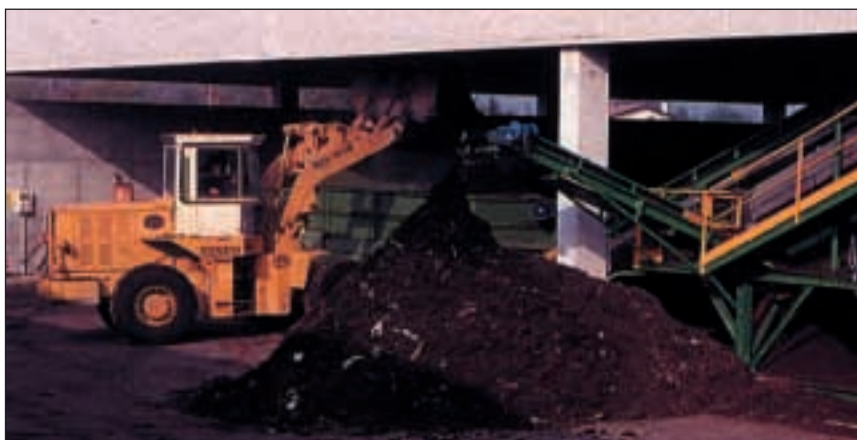
Armazenamento do composto final na central de compostagem
