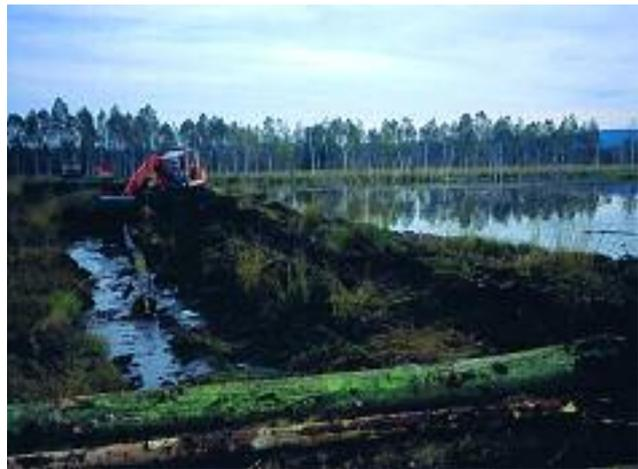
**Bild 5:** Der Enddamm des Egelseegrabens wurde nach unerwarteter starker Torfsetzung in der Dammschüttung nachträglich verstärkt. (Hinter dem Bagger die für den Torfransport benötigte Moorraupe)
