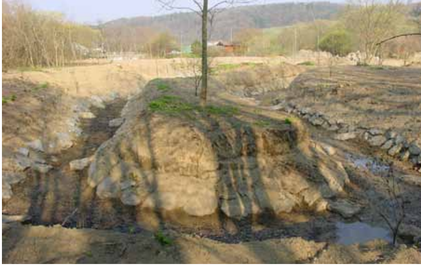
LIFE99 NAT/A/006054 (înainte) Construcția unui canal secundar la barajul „Eibelsau” și a unui canal cu apă curgătoare și cu vegetație, care permite peștilor să migreze în amonte.
