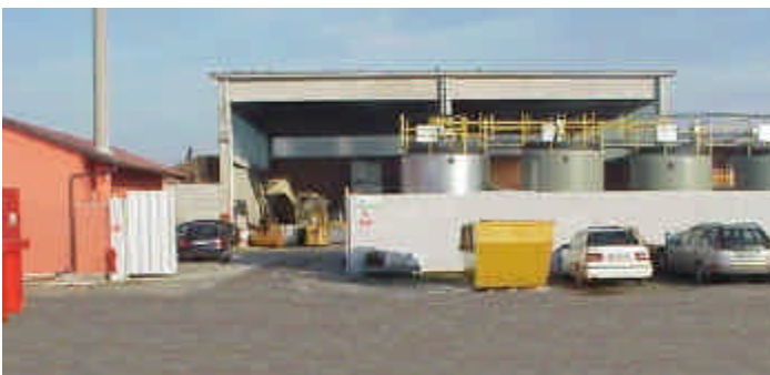
Ufficio e ingresso del deposito attuale.
