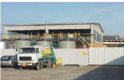
Uscita del deposito attuale.
