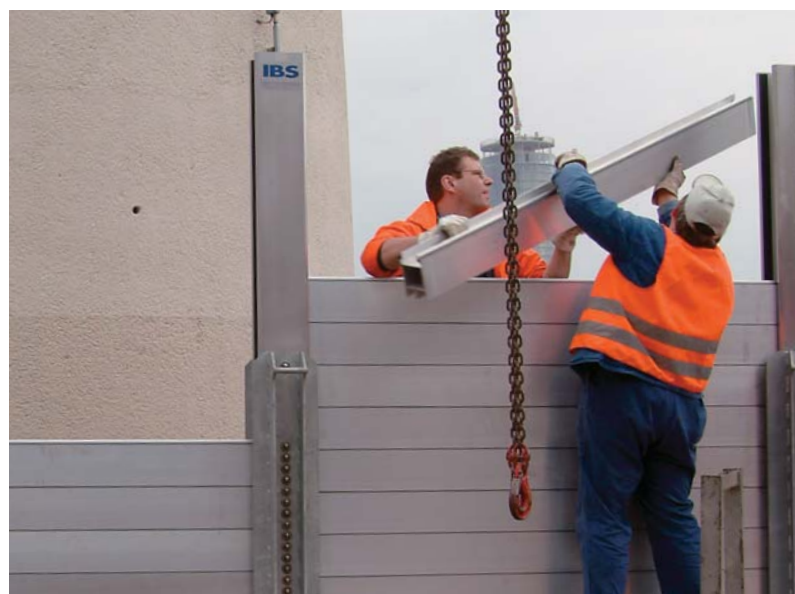
Aufbau einer mobilen Hochwasserschutzwand; Bild: P.Jost PHOTOGRAPHY
