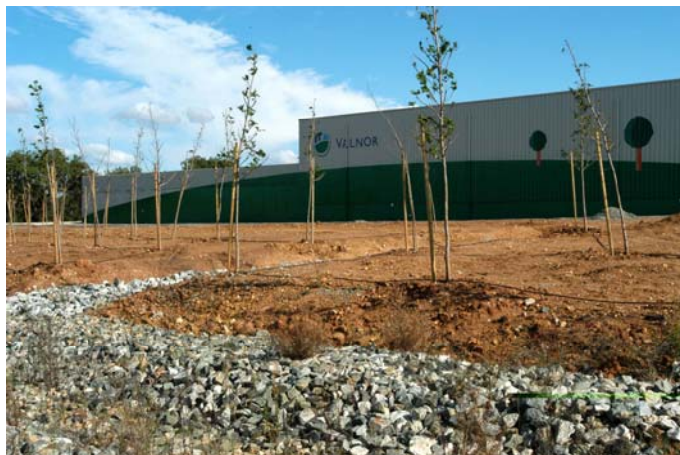
Foto 4 – Nave de armazenamento de REEEs
