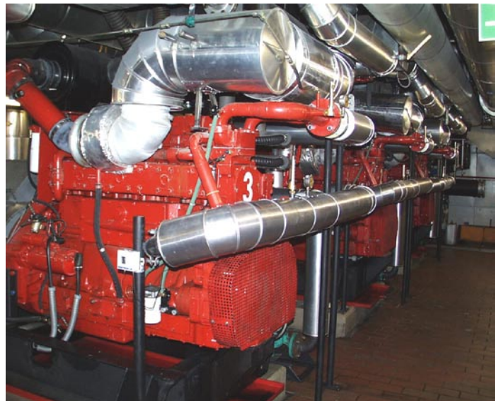
Bild: BHKW - Modul im KKH
