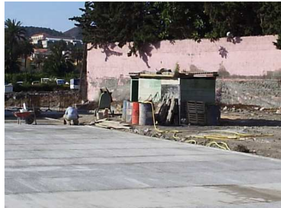
Llena de bidones para la obra
