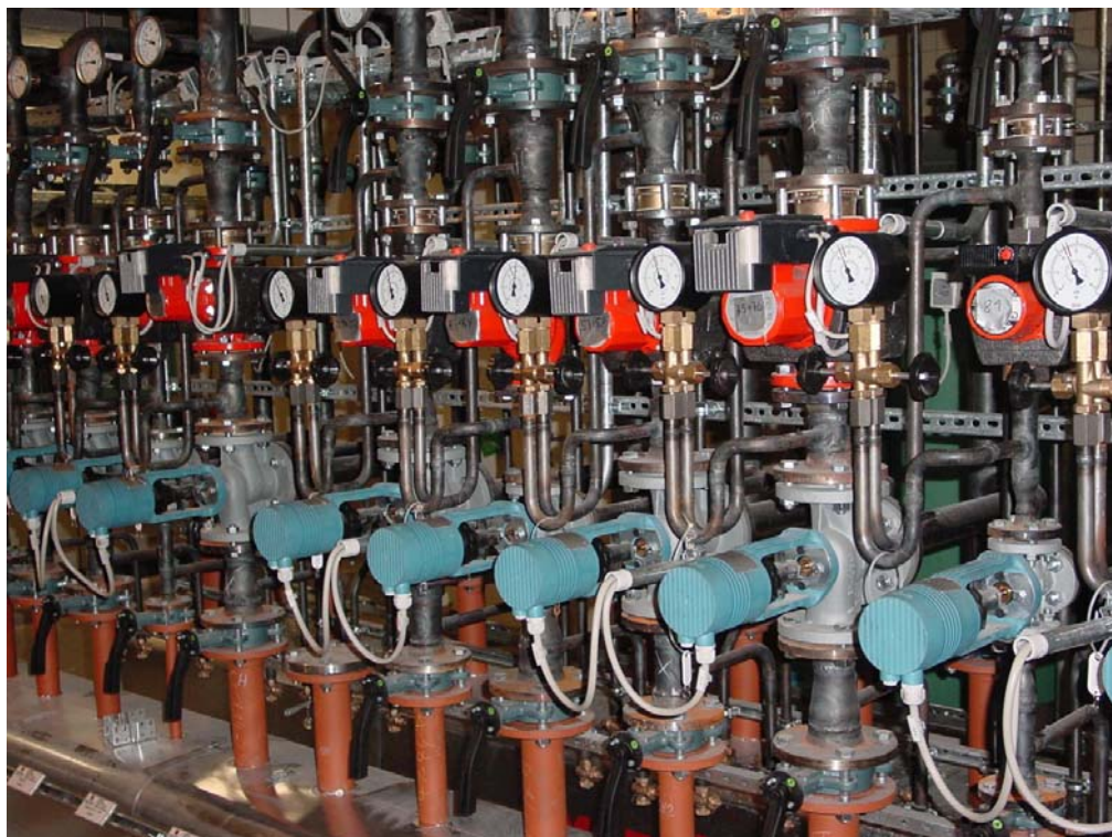
Neue Heizanlage der Max-Eyth-Schule 2003 im Rohbau ohne Isolierung
