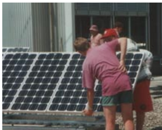
Auf dem Dach der Elektronischule
