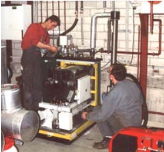
Einbau des Mini-Blockheizkraftwerks
