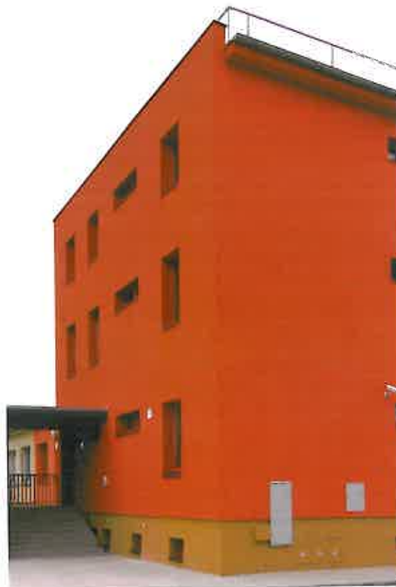
Foto Hasičská Zbrojnice
