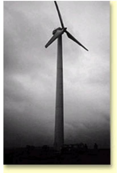
Windkraftanlage Hausen v. Wald
