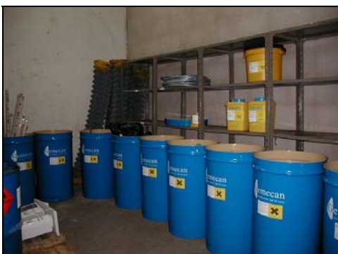
Cuarto de almacenamiento de residuos peligrosos en el C.V. El Portillo
