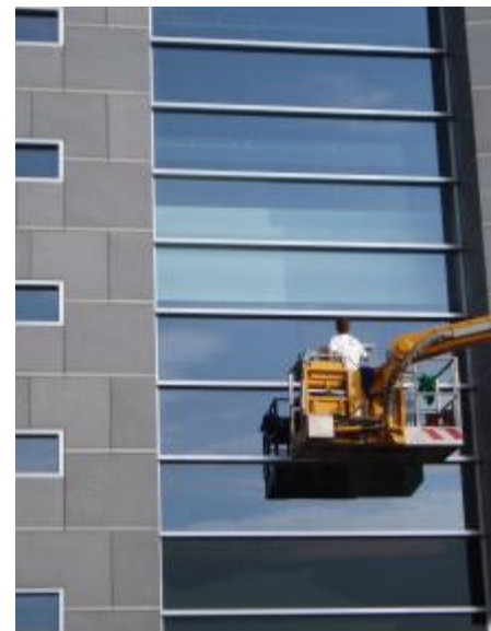
Fassade, Landhaus St. Pölten
