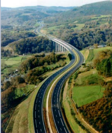
Autovía del Noroeste. Tramo: Villartelín-Cereixal. Viaducto de Baralla.
