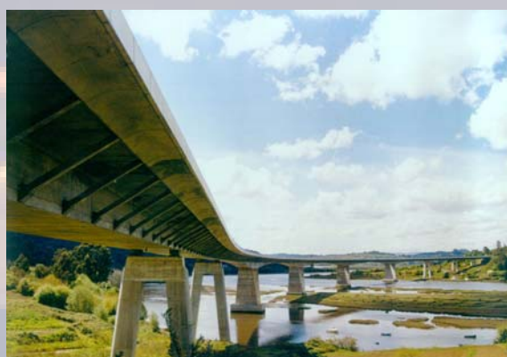
Autopista del Atlántico. Viaducto sobre la Ría de Betanzos.
