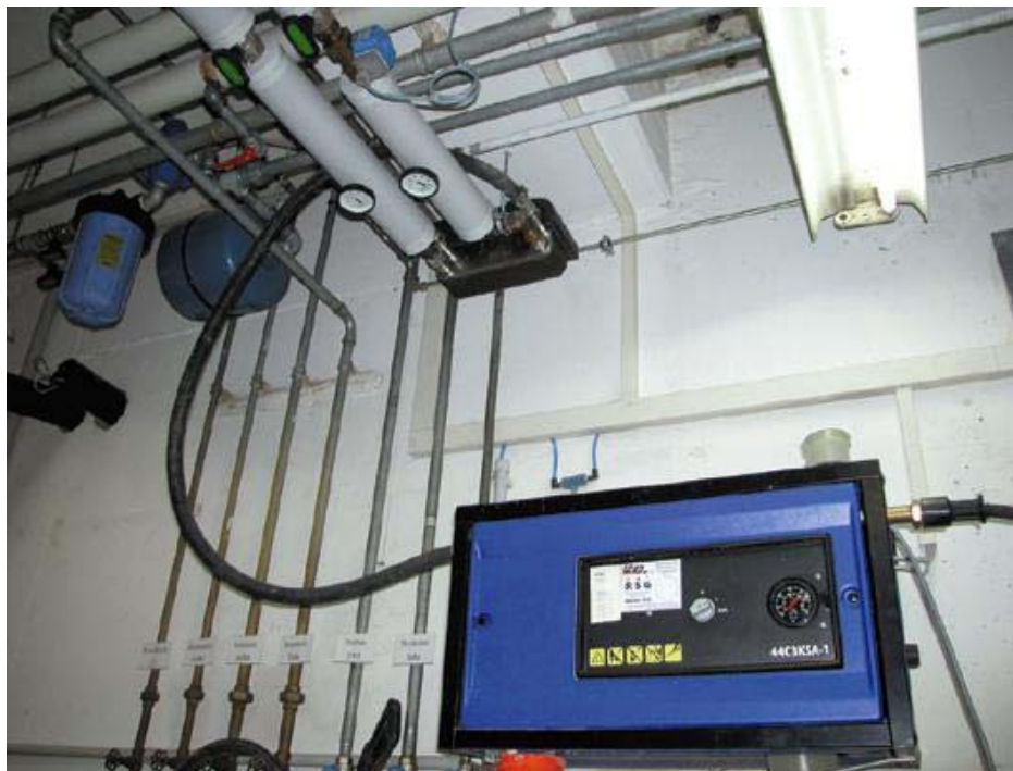
Hochdruckdampfkompresseur mit Plattenwärmetauscher
