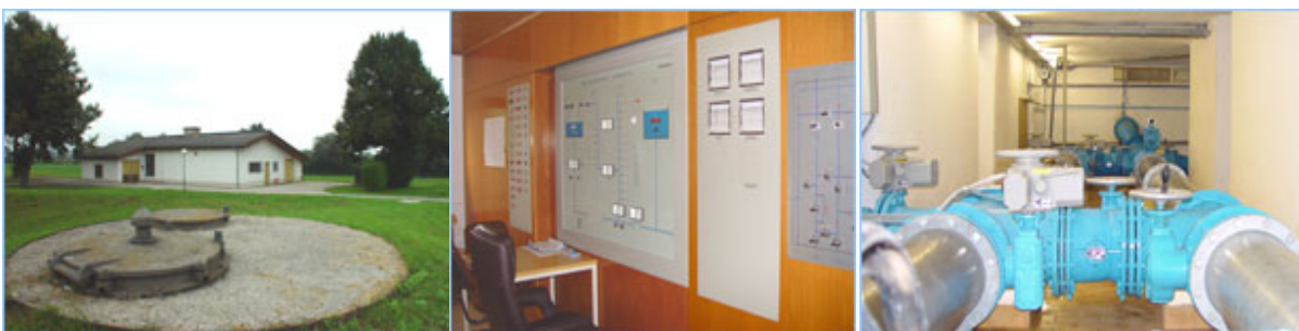
Betriebsgebäude, Schaltwarte und Rohrkeller in Straschitz II (Quelle: Wassergewinnung)
