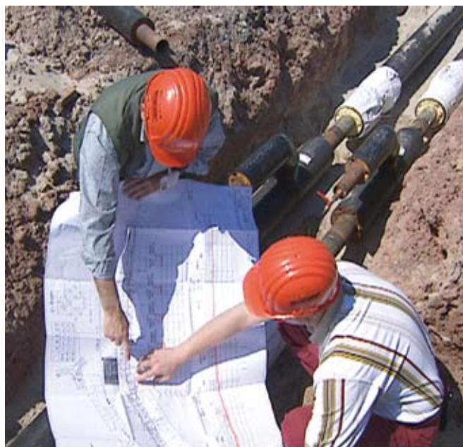
Für den Ausbau und die Erneuerung des rund 767 km langen Gasrohrnetzes investierten die Stadtwerke im Jahr 2007 rund 4,6 Millionen Euro
