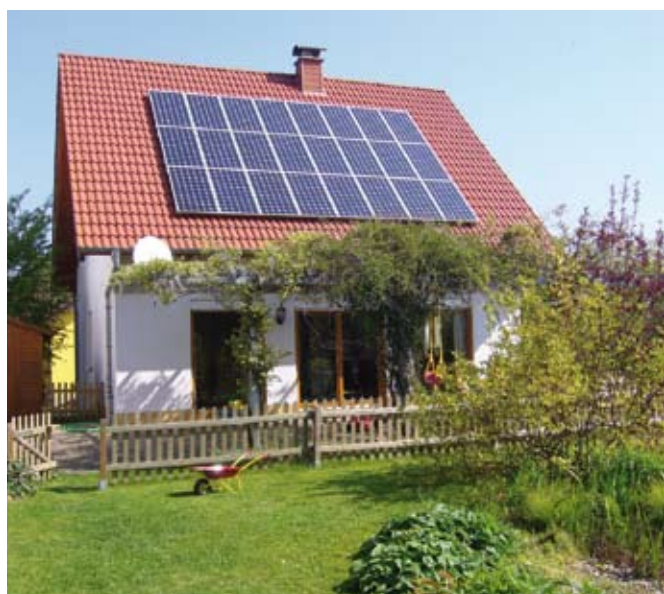
Photovoltaik-Anlage auf einem Einfamilienhaus. Realisiert wurde die Anlage im Rahmen der PV-Initiative der Stadtwerke (PV-Privat).
