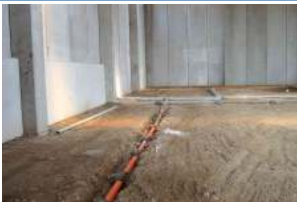
Figura 5.2 Dettaglio griglia pressa + canalizzazione alla vasca stagna
