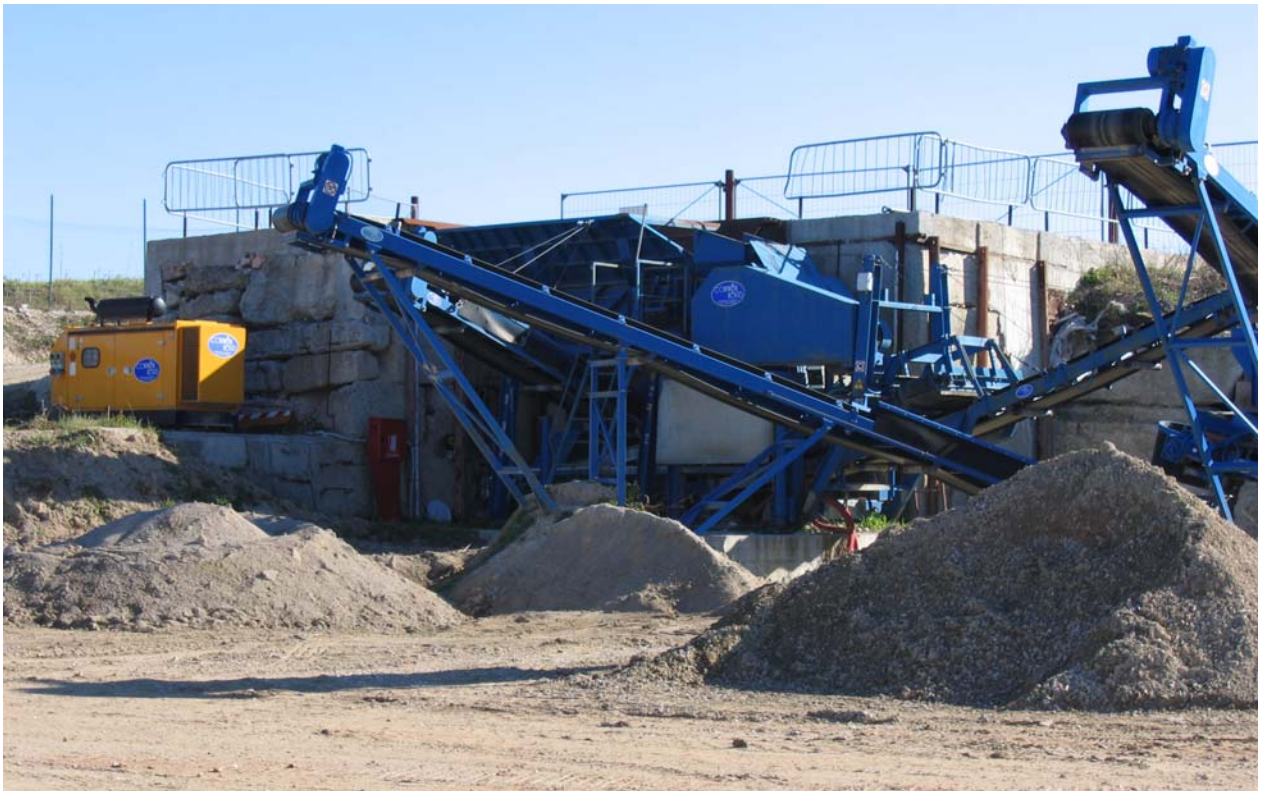
Fig.6 Dettaglio dell'impianto mobile di frantumazione primaria
