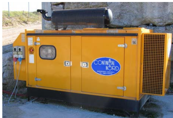
Fig.19 Serbatoio per il gasolio e gruppo elettrogeno
