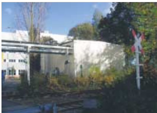
Eingehauste Strip-/Aktivkohlereinigungsanlage der DaimlerChrysler AG
