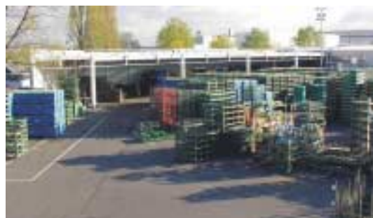
Beim Zusammenklappen von Gitterboxen und durch die Verkehrsbewegungen lässt sich Lärm im Bereich des Leergutplatzes nicht gänzlich vermeiden. Zum Schutz unserer Nachbarn haben wir diesen Platz eingehaust sowie Tor und Wände schallabsorbierend ausgelegt.
