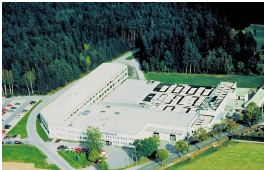
Freigegeben vom BMLV mit zl. 13.088/672-1.6/92
